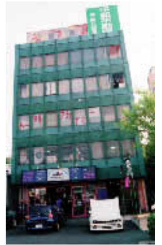
外観はそのままに、内装だけリフォーム & リノベーションしました。
